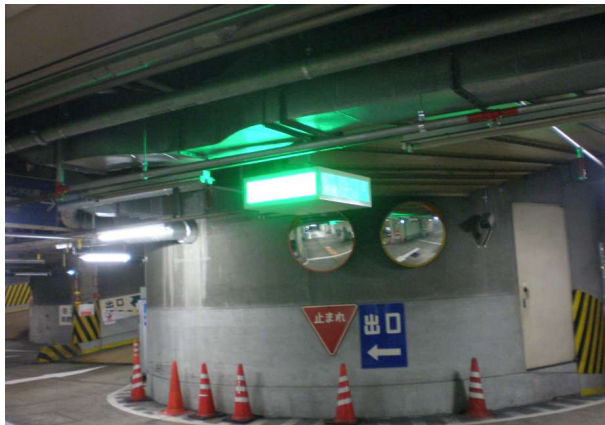
危険箇所に信号灯を設置
