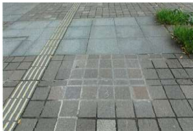
歩道（敷地内）の安全性の向上
